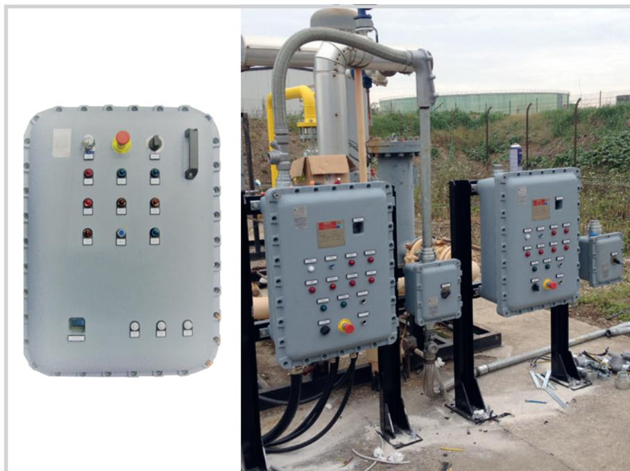
Gli scambiatori di calore elettrici e le batterie sono forniti con Quadri elettrici di controllo, costruiti con termoregolatori Thyristor e PID per un controllo di precisione.
